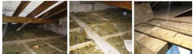
Рис. 16. Намокание утеплителя
