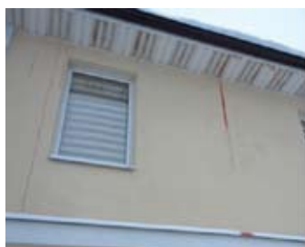
Рис. 1. На карнизном вылете появляется капель или образуются сосульки (иногда розового или синего цвета)
