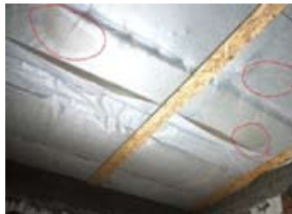
Рис. 3. На потолке образуются лужи на внутренней поверхности пароизоляции
