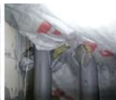
Рис. 8. Негерметичные проходки
