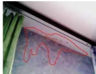
Рис. 4. Образуются мокрые пятна на потолке (для совмещенных утепленных крыш – преимущественно у стены)
