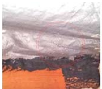
Рис. 5. Образование конденсата на наружной поверхности пароизоляции
