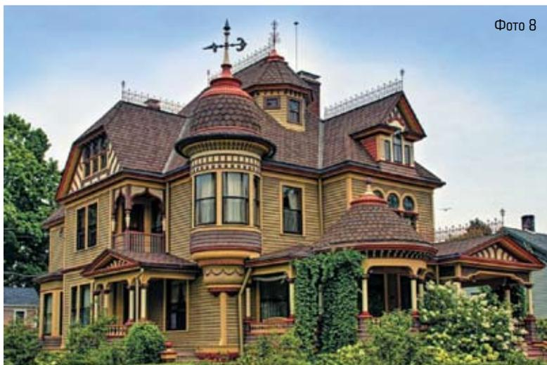
материал вряд ли прибавит (с таких углов его блеск виден лишь с расстояния 150-300 метров), а вот усложнит конструкцию кровли наверняка. Ведь для таких углов под сланец требуется устройство дополнительной (второй) кровли.
