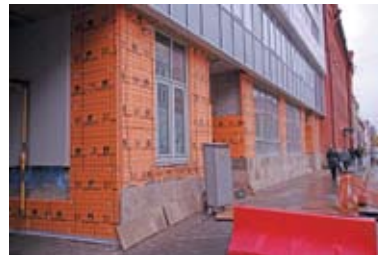
Рис. 3. Фасадная система ПЕНОПЛЭКС® ФАСАД PRO
