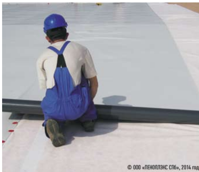
Фото 2. Кровля складского терминала, Санкт-Петербург
