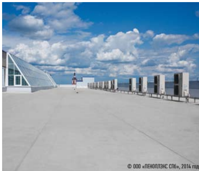
Фото 1. Кровля гостиничного комплекса, Рязань
