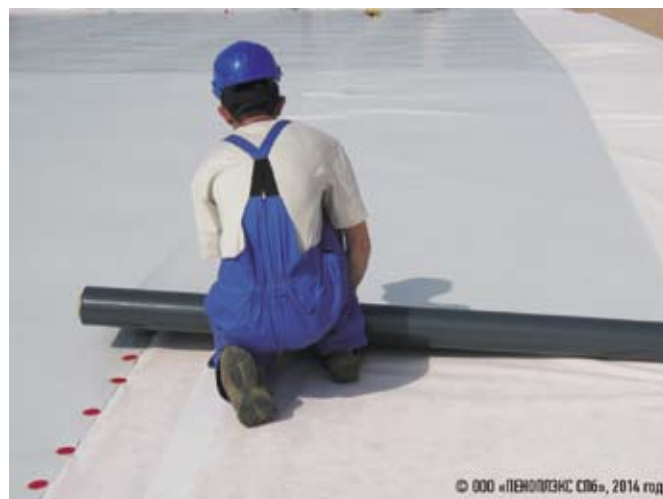
Фото 2. Кровля складского терминала, г. Санкт-Петербург
