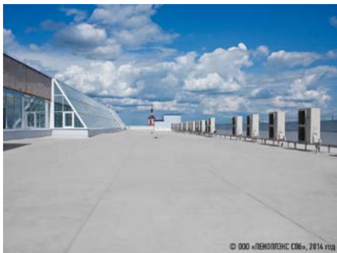
Фото 1. Кровля гостиничного комплекса, г. Рязань
