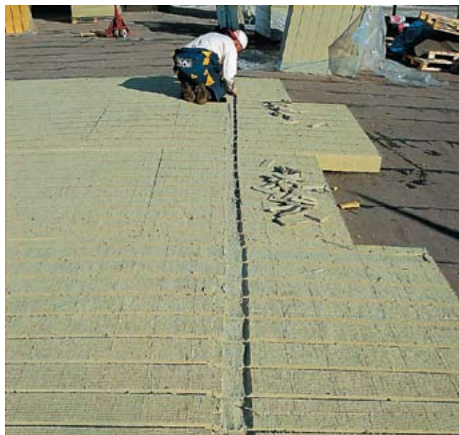
Рис. 3. Соединение канавок сборным коллектором
