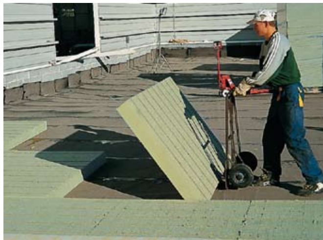
Рис. 2. Укладка теплоизоляционных плит с канавками PAROC ROS 30g (ROS 40g)
