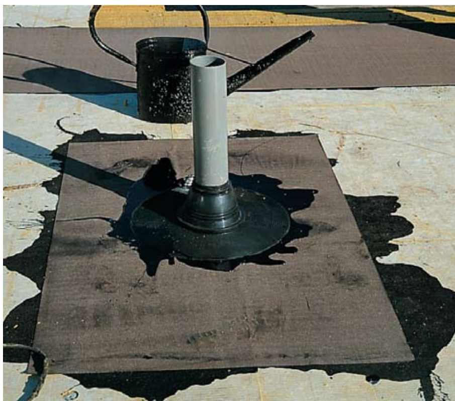
Рис. 5. Установка вентиляционного дефлектора
