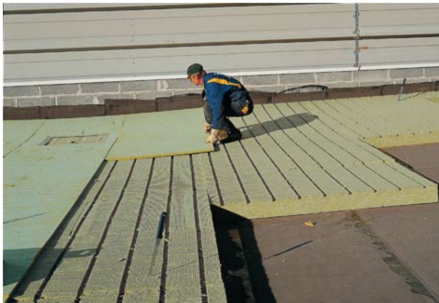
Рис. 4. Укладка теплоизоляционных плит PAROC ROB 80t (ROB 60) – верхний слой
